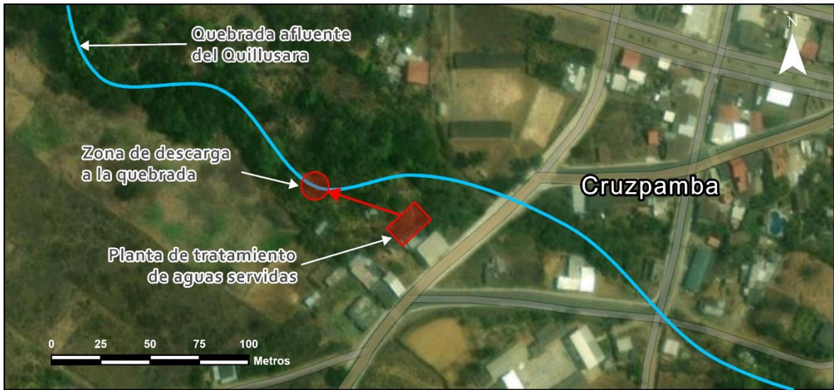
Figura 8: Planta de tratamiento de aguas servidas de Cruzpamba
