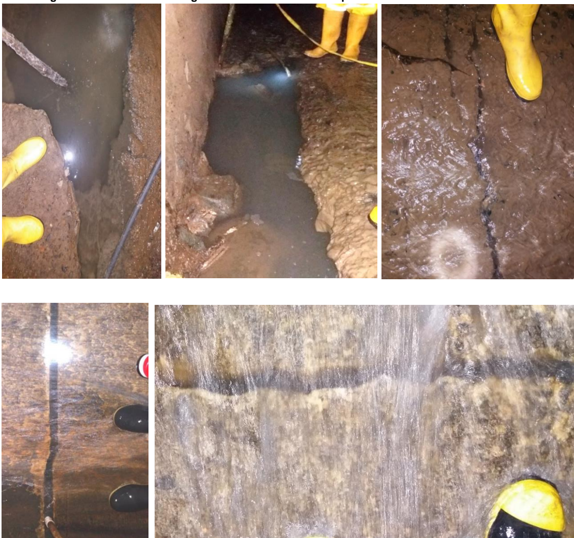
Imagen 8: Documentación fotográfica del estado crítico del piso del embaulado de la ciudad de Celica.
