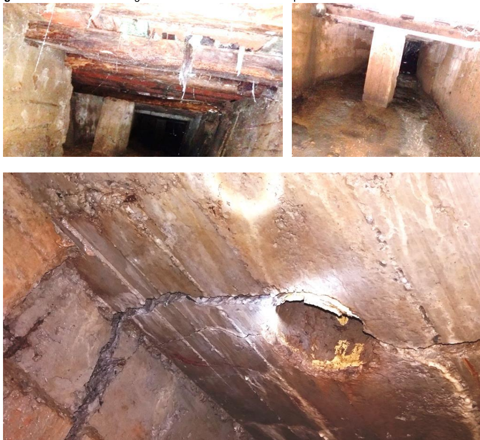
Imagen 5: Documentación fotográfica del deterioro de la cara superior del embaulado de la ciudad de Celica
